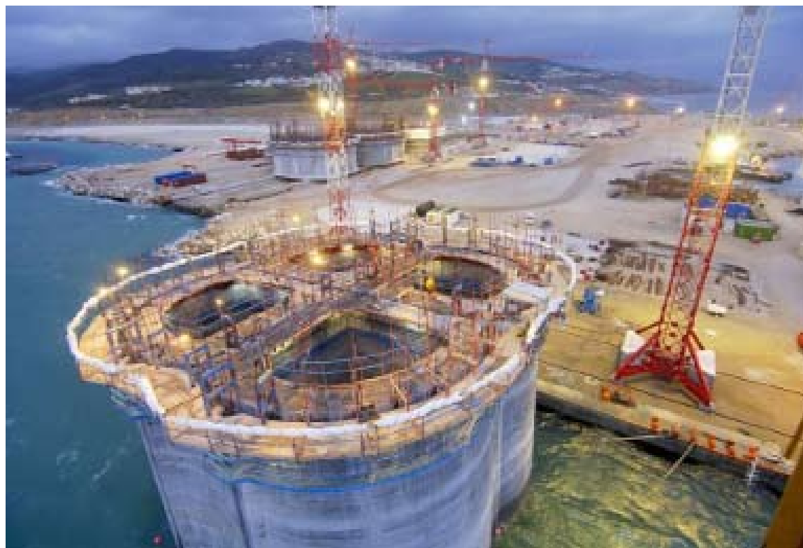
Caisson en attente port Tanger Med 1
